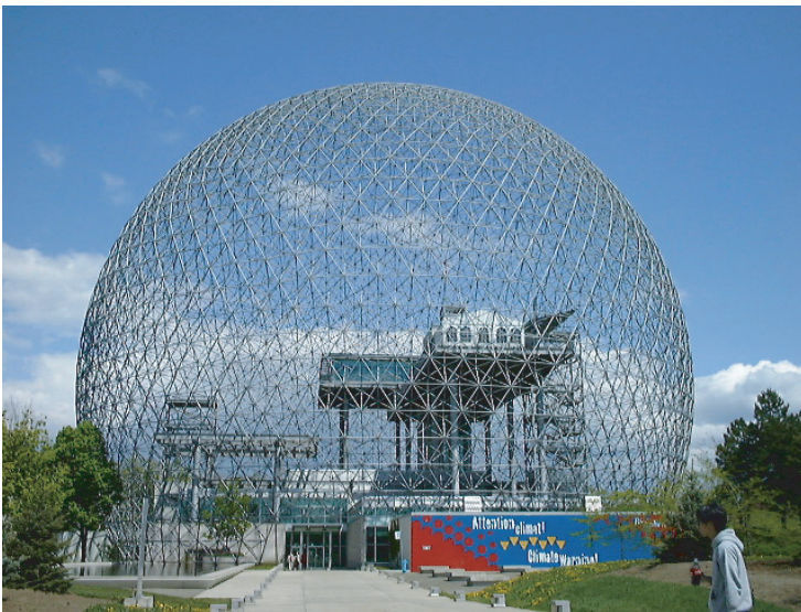
図1. 左:モントリオールにあるバイオスフェア(Buckminster Fuller 設計, 1967)。右:正20面体分割格子。格子分割数5の格子配置。
